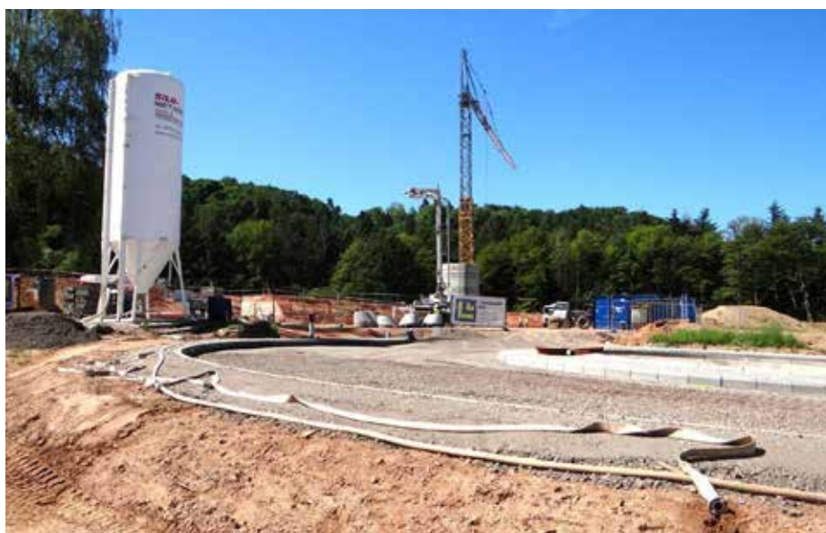
In waldreicher, ruhiger Lage entsteht zur Zeit das künftige Palliativzentrum Schmetterling. Schon von weitem sind Kräne und Baumaschinen zu sehen © Hollinger
