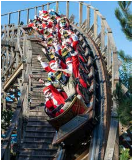
Über einen Kilometer lang, 40 Meter hoch, 100 km/h schnell, Fliehkräfte von wahnsinnigen 3,5G in den Kurven und sogar Airtime-Phasen machen sie zum Magnet für jeden Achterbahn-Junkie © Europa-Park
