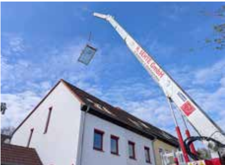
Die energetische Dachfenstersanierung ist ein Spezialgebiet des Handwerksbetriebes © Sehte
