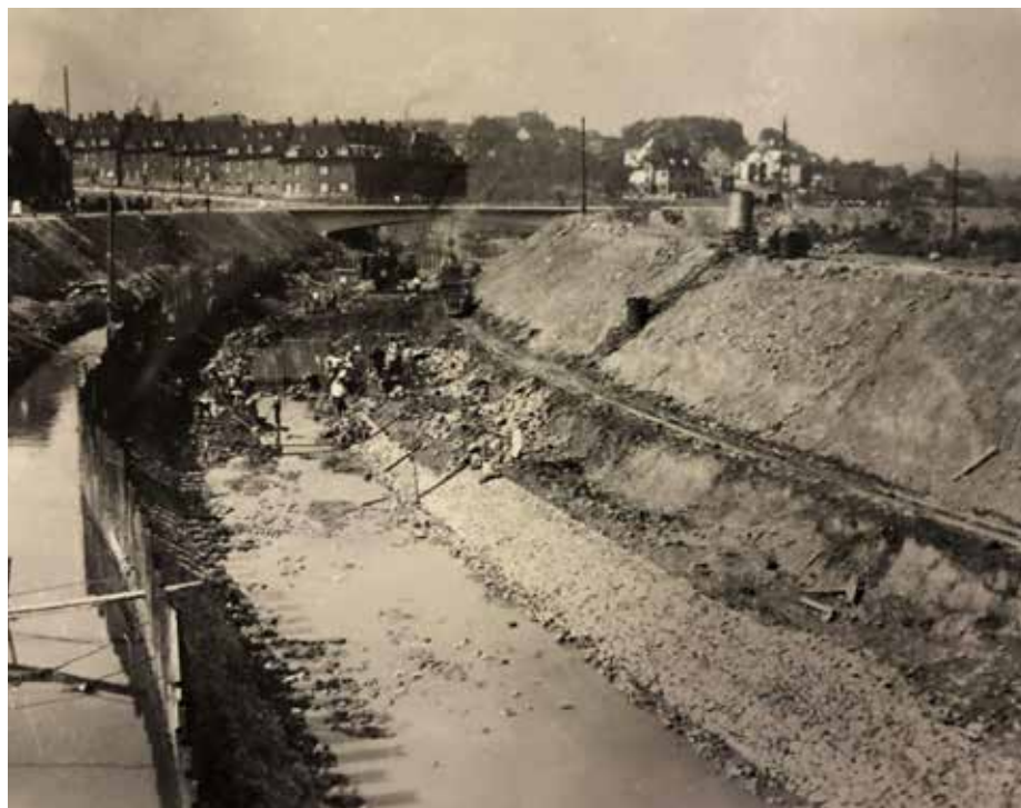
Bliesregulierung ab 1935 Blickrichtung Innenstadt © Stadtarchiv Neunkirchen
