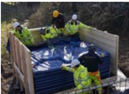
Der spezielle Kanal-Schlauch wird aus seinem Paket entfaltet
