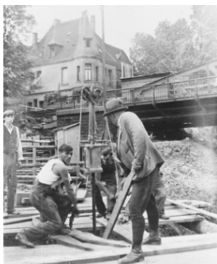
Arbeiten am Hammergraben unterhalb der Brückenstraße © Archiv Schwenk/HVSN
