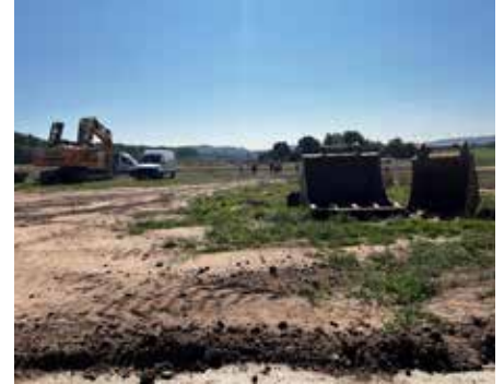
Im Gewerbegebiet G9 sind die Kanalbauarbeiten abgeschlossen © Linda Barth
