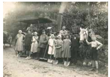
Straßenneubau Distrikt lange Tannen mit Karl Konrad © Archiv Britz
