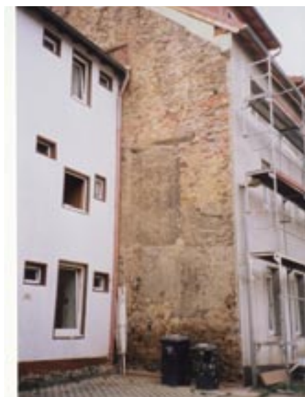
Schlossstraße 22-ehemaliger Schloss Mittelrisalit mit original Mauerwerk und Holzsturz über zugemauelter Tür © Schwenk 650/4
