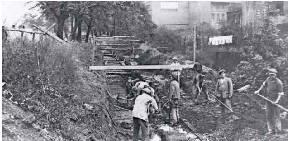
Arbeiten am Hammergraben zwischen der Millerstraße und den verbliebenen Linden © AS/ HVSN
